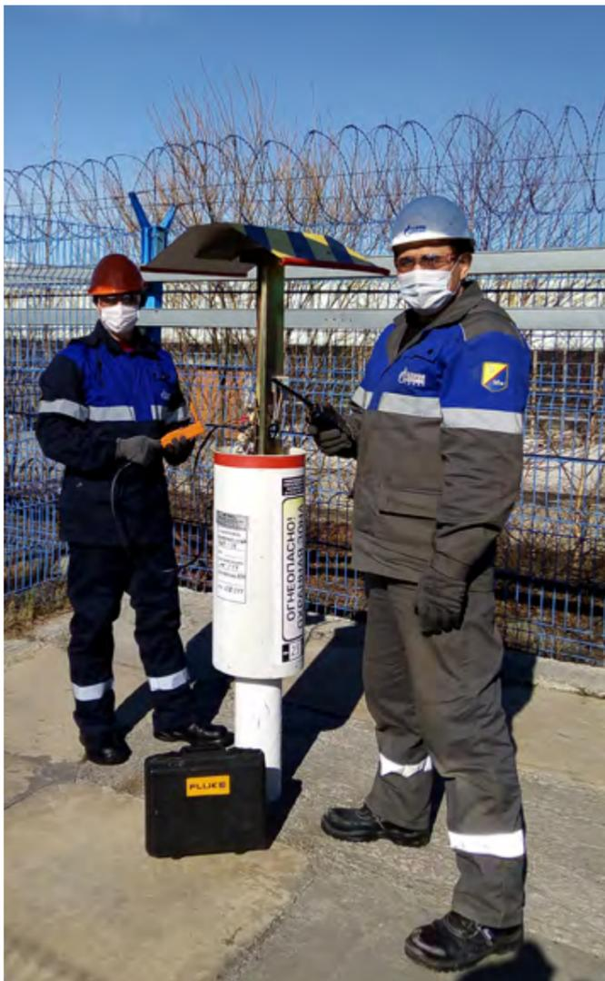
Сотрудники участка электрохимзащиты Камчатского ЛПУМГ выполняют измерения разности потенциала «труба – земля» на газопроводе-отводе к базе филиала
