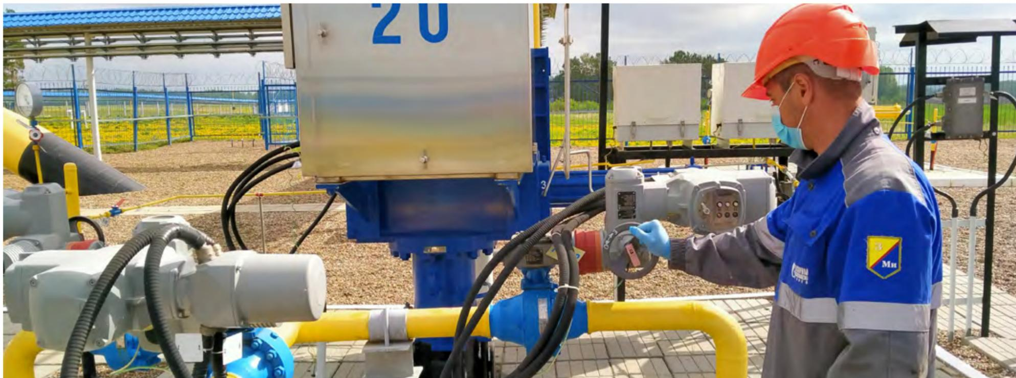
Слесарь по ремонту технологических установок Юргинского ЛПУМГ по распоряжению диспетчера осуществляет визуальный контроль дистанционной перестановки запорной арматуры на узле подключения компрессорной станции «Просоково»
